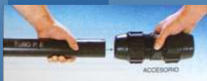
Aproximación del tubo de P.E. al accesorio
